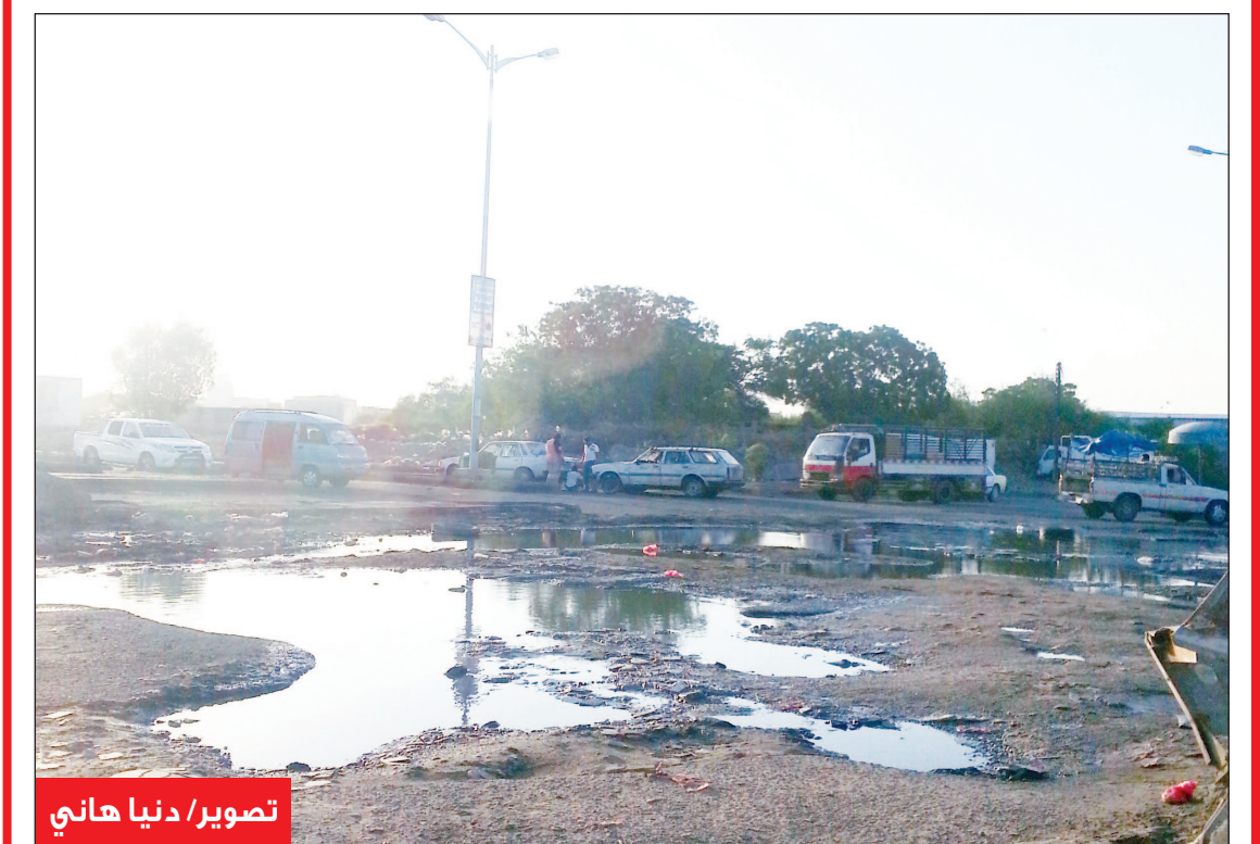
تصوير/ دنيا هاني طريق الممدارة الجديدة (أمام محطة البترول) له فترة طويلة يعاني من المجاري الطافحة التي تنبعث منها روائح كريهة تززع كل المارين منه.. نرجو وضع حل لهذا الطريق أيها الجهات المعنية!!
