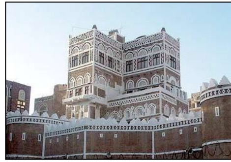
في قصر عمدان حتى يتم الاستعانة بخبراء في مجال ترميم وصيانة المباني والقلاع
