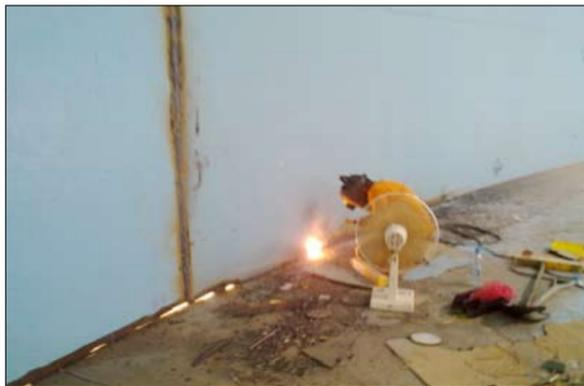
\* وكذا في ما يخص خزان البرزخ، حيث واجهت الطاقم مشكلة كيفية إزالة الصفائح الحديدية المتهاكة من أرضية الخزان، حيث يتعين أولاً استبدالها بصفائح جديدة، ورفع القوائم الحديدية الداعمة لسقف الخزان، ونظراً لحجم الخزان الذي يبلغ قطره (55 متراً) كان لابد من الحذر الشديد عند رفع هذه الأعمدة، حتى لا ينهار سقف الخزان بالكامل.. ويفضل من الله تمت صيانته دون حوادث تذكر.
