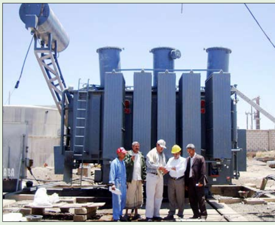
■ أثناء تركيب المحول الكهربائي الجديد
