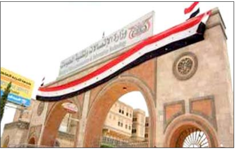
مبنى وزارة الاتصالات
