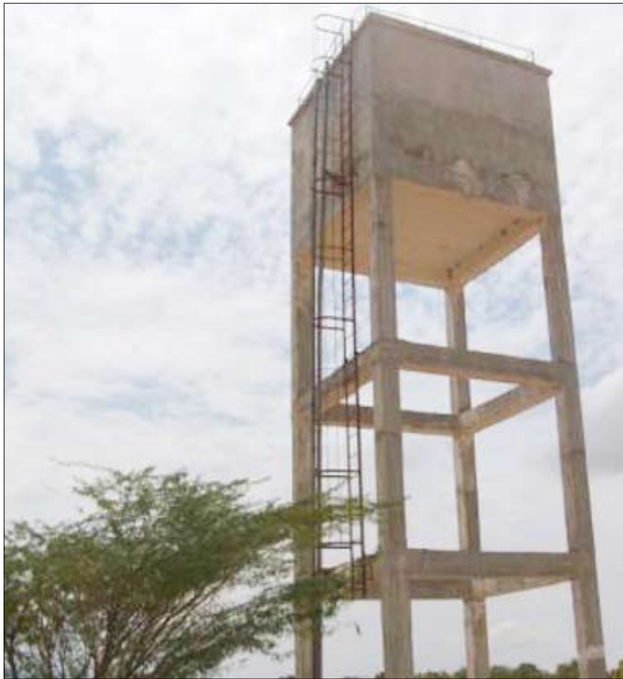
مشروع مياه الهديمية
