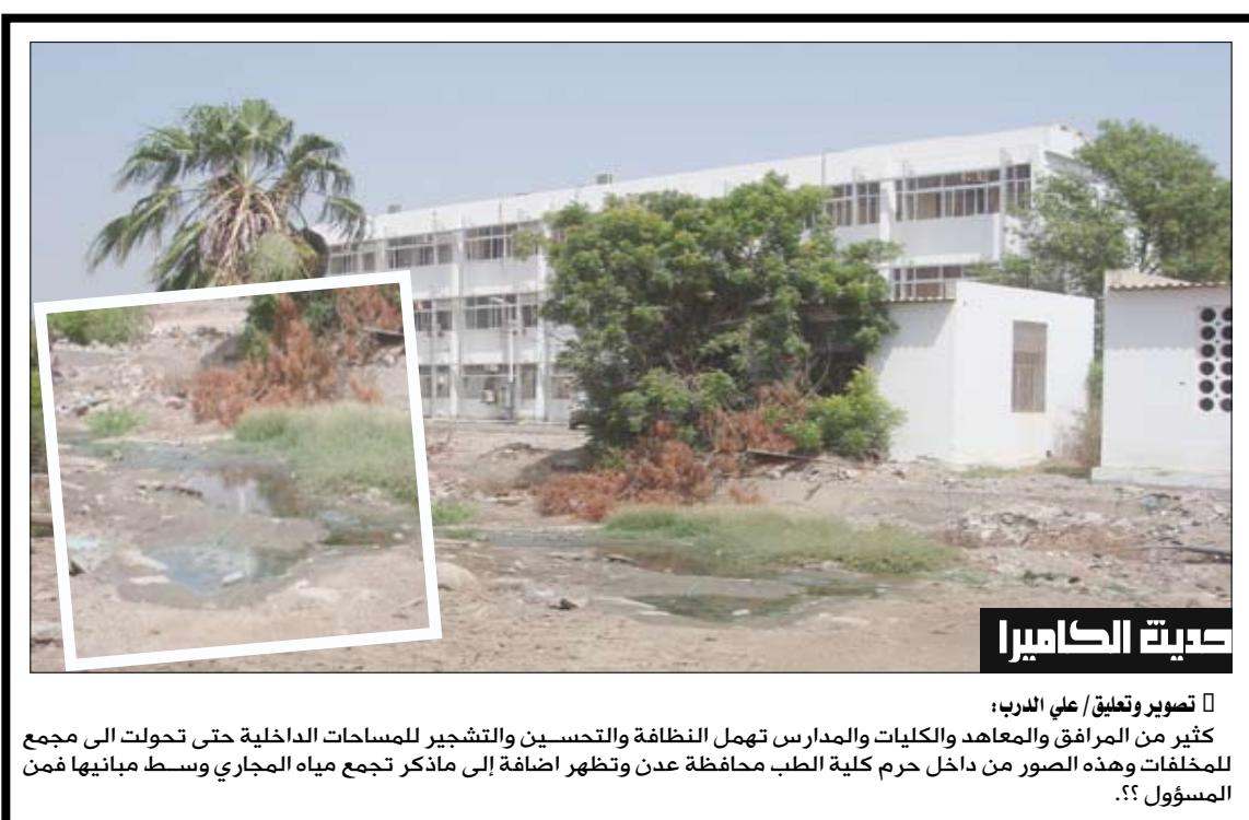
كعبة الكاميرا تصوير وتعليق / علي الدرب، كثير من المرافق والمعاهد والكليات والمدارس تهمل النظافة والتحصين والتشجير للمساحات الداخلية حتى تحولت الى مجمع للمخلفات وهذه الصور من داخل حرم كلية الطب محافظة عدن وتظهر اضافة الى ماذكر تجمع مياه المجاري وسط مبانها فمن المسؤول؟؟
