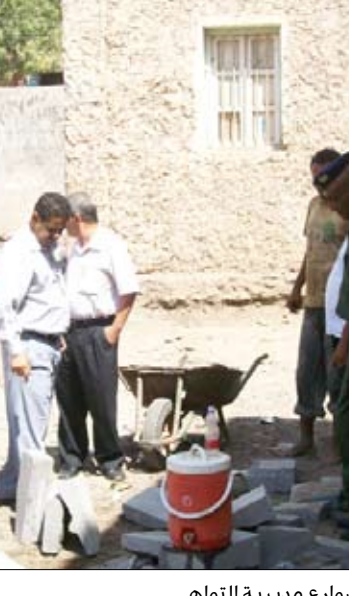
الشييباني يتفقد رصف شوارع مديرية التواهي
