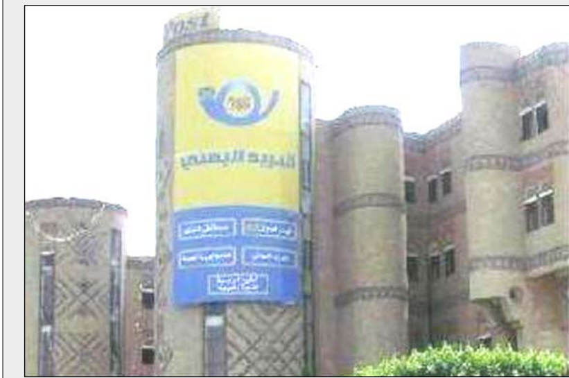
مبنى الهيئة العامة للبريد
