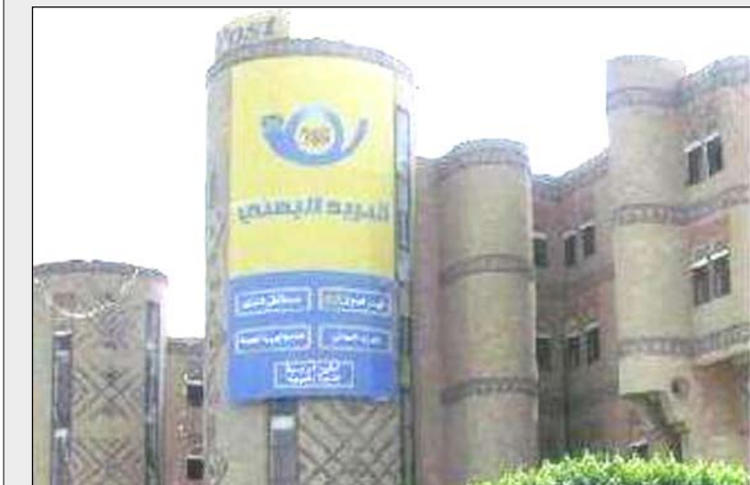
مبنى الهيئة العامة للبريد
