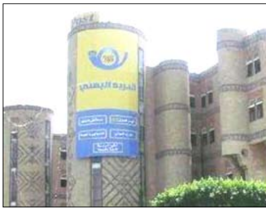
مبنى الهيئة العامة للبريد
