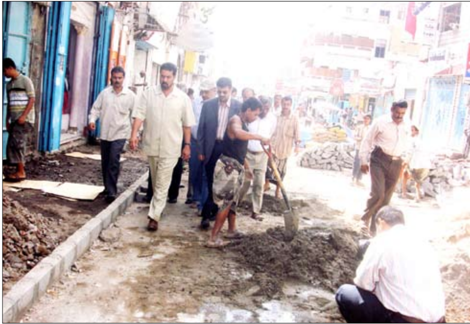
قيادة محافظة عدن أثناء تفقدها عملية رصف الشوارع
