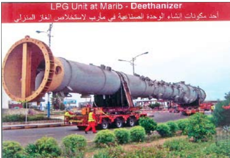
مشروع الغاز المنزلي انشاء وحدة
