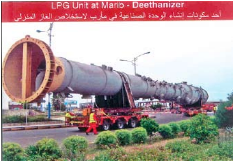
مشروع الغاز المنزلي انشاء وحدة
