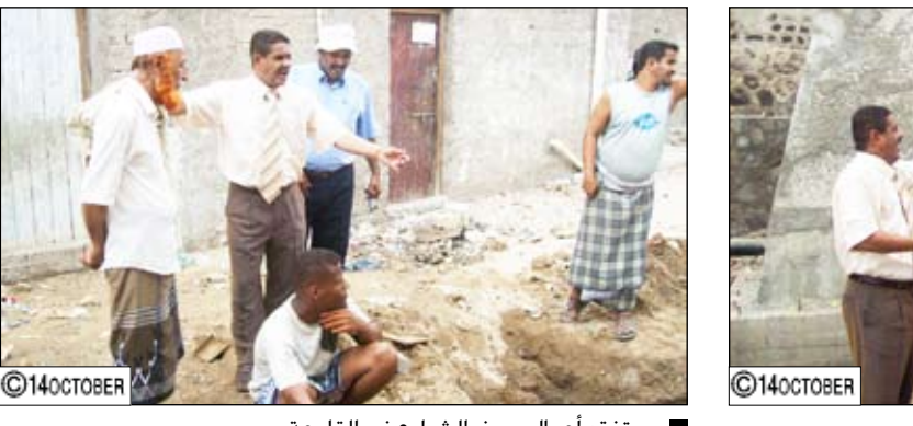
الشيخاني يتفقد أعمال تأهيل خزان الفتح
