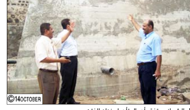
الشييباني يتفقد أعمال تأهيل خزان الفتح
