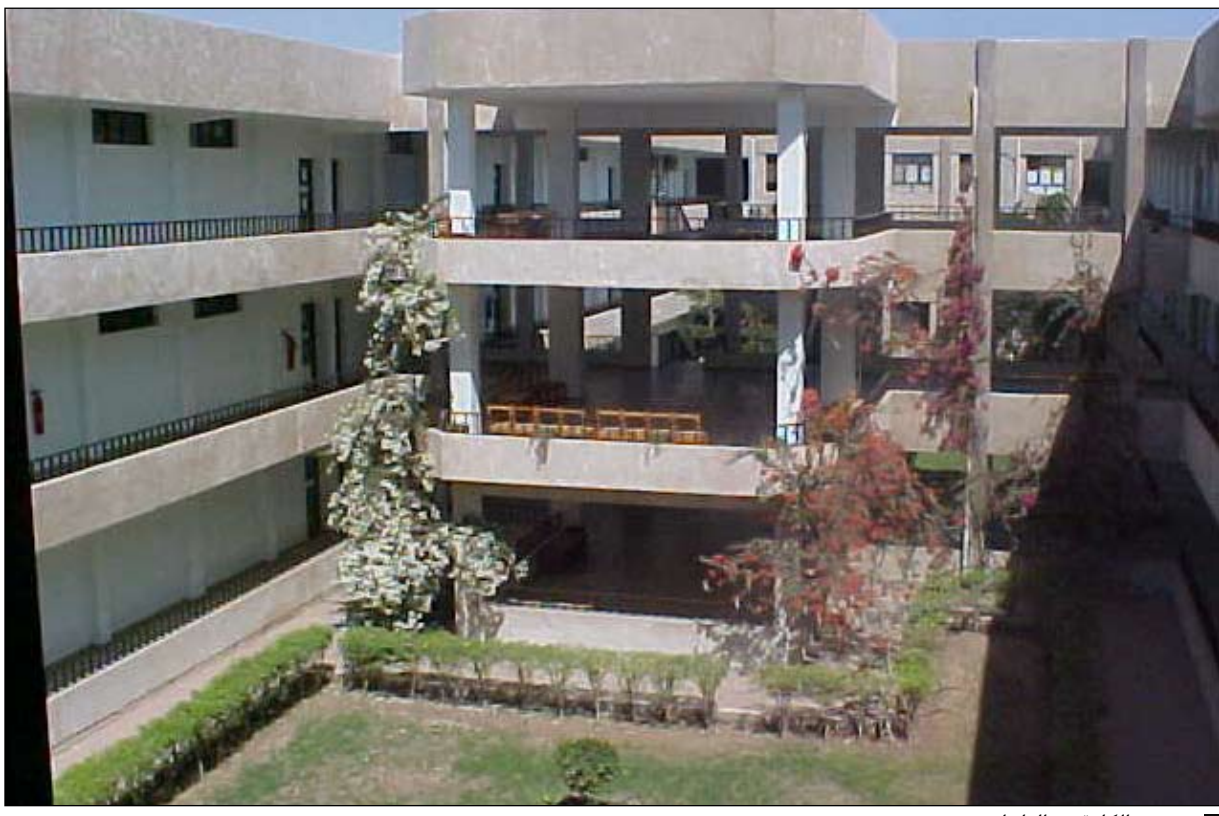
مبنى الكلية من الداخل
