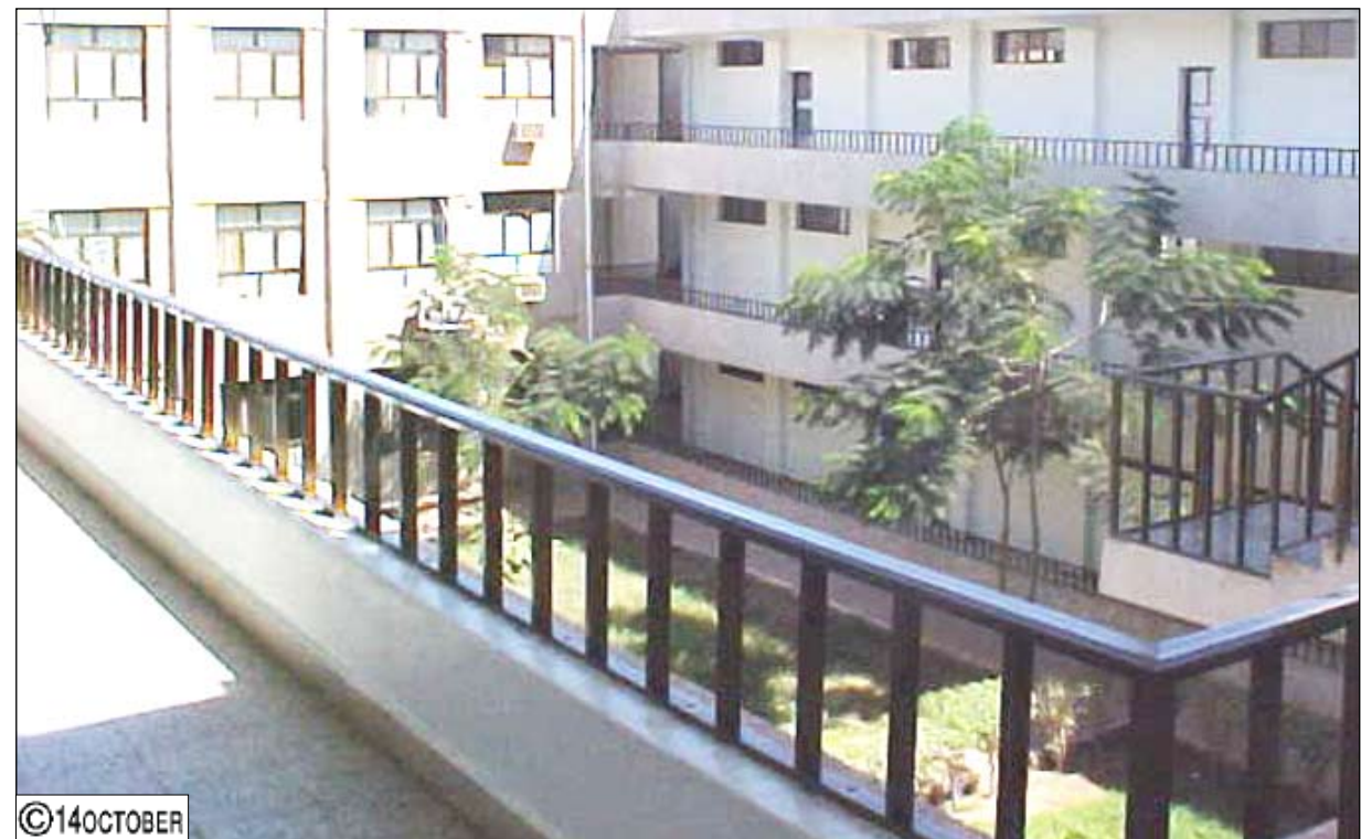
مبنى الكلية من الداخل
