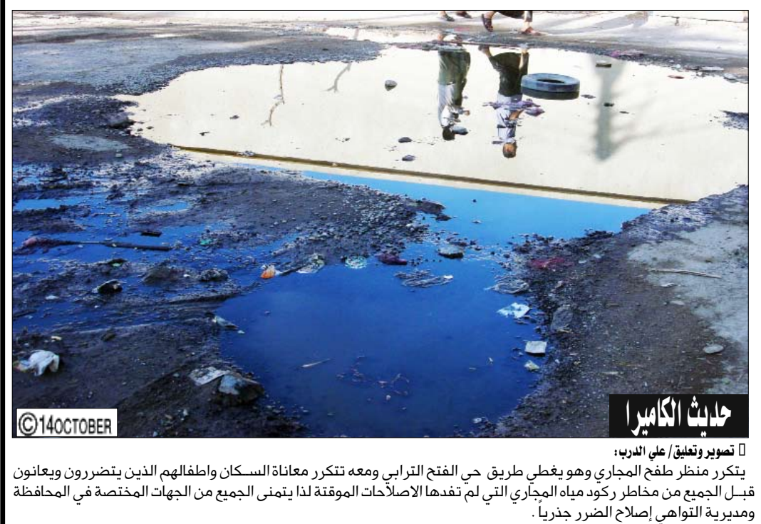
حادث الكابيرا تصوير وتعليق/ علي الدرب: يتكرر منظر طغف المجاري وهو يعطى طريق حي الفتح الترابي ومعه تنكسر معاناة السكان وأطفالهم الذين يتضررون ويعانون قبل الجمع من مخاطر ركود مياه المجاري التي لم تعد لها الإصلاحات الموقته لذا يتمنى الجميع من الجهات المختصة في المحافظة ومديرية التواهي إصلاح الضرر جذرياً.
