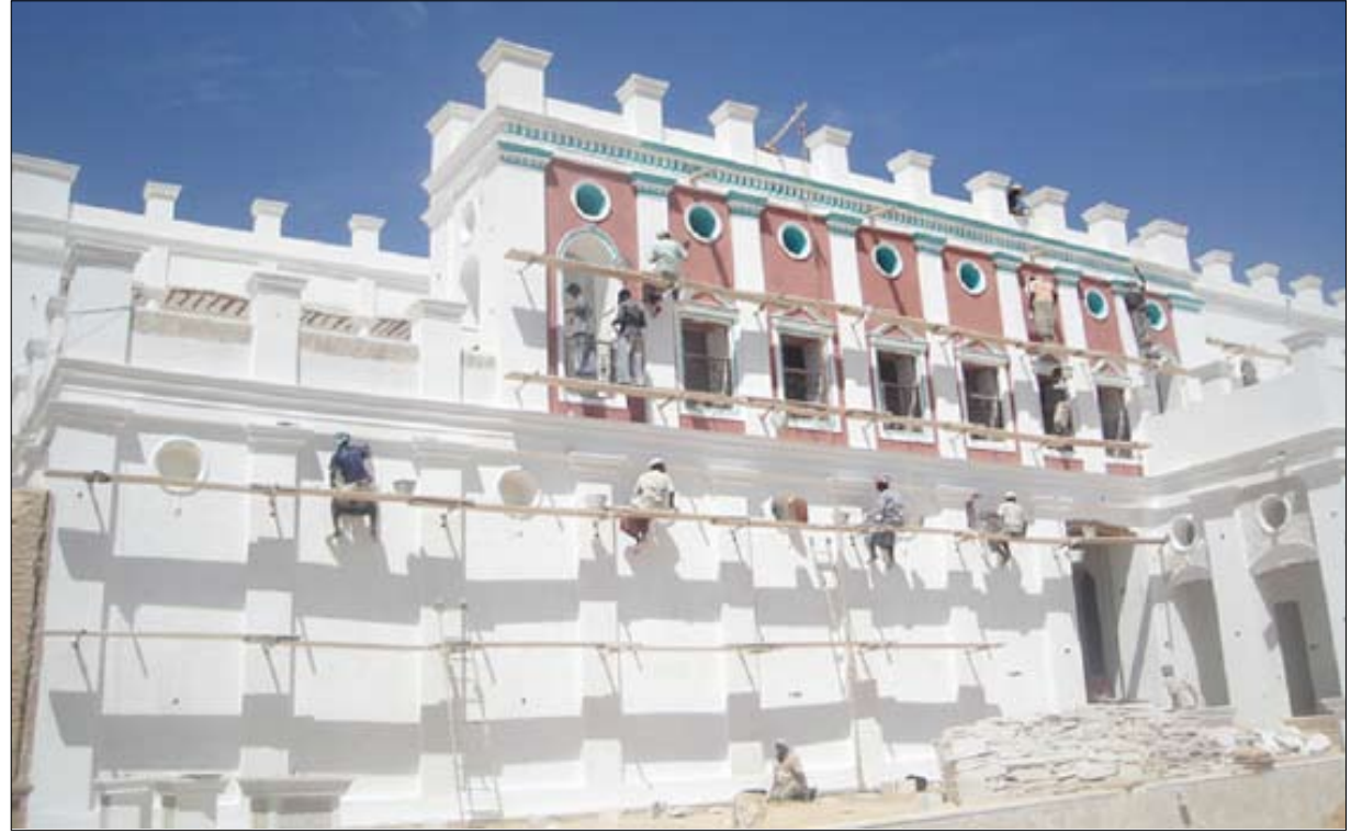
من أعمال الترميم والصيانة في مدينة تريم
