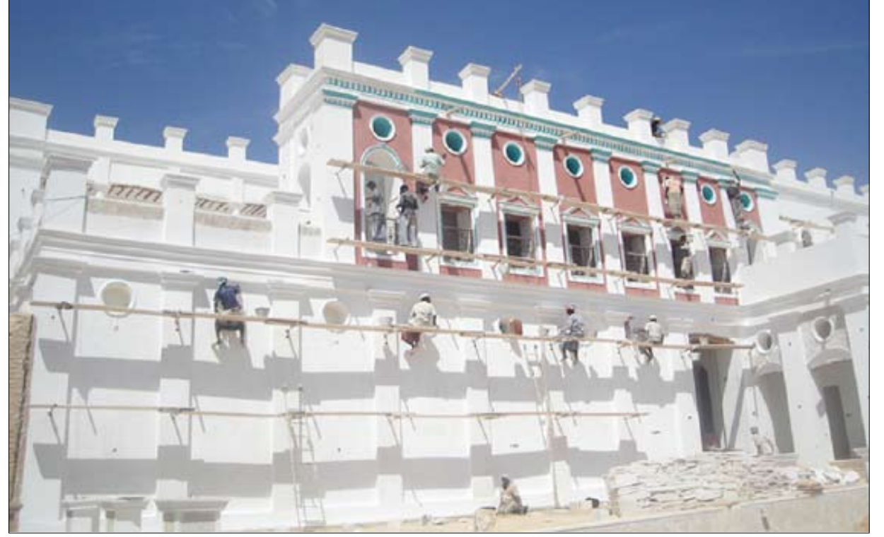
من أعمال الترميم والصيانة في مدينة تريم
