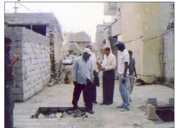
أعمال الصرف في مديرية صيرة
