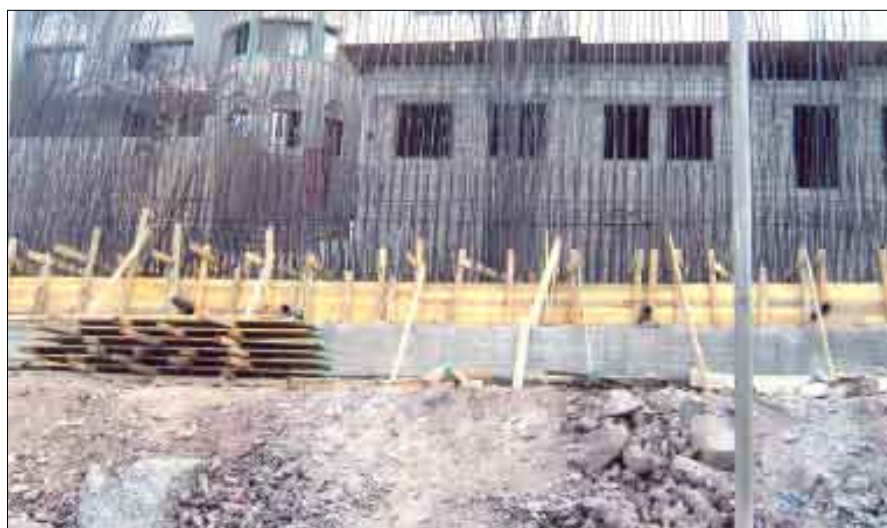
بناء خزان للمياه بالمديرية
