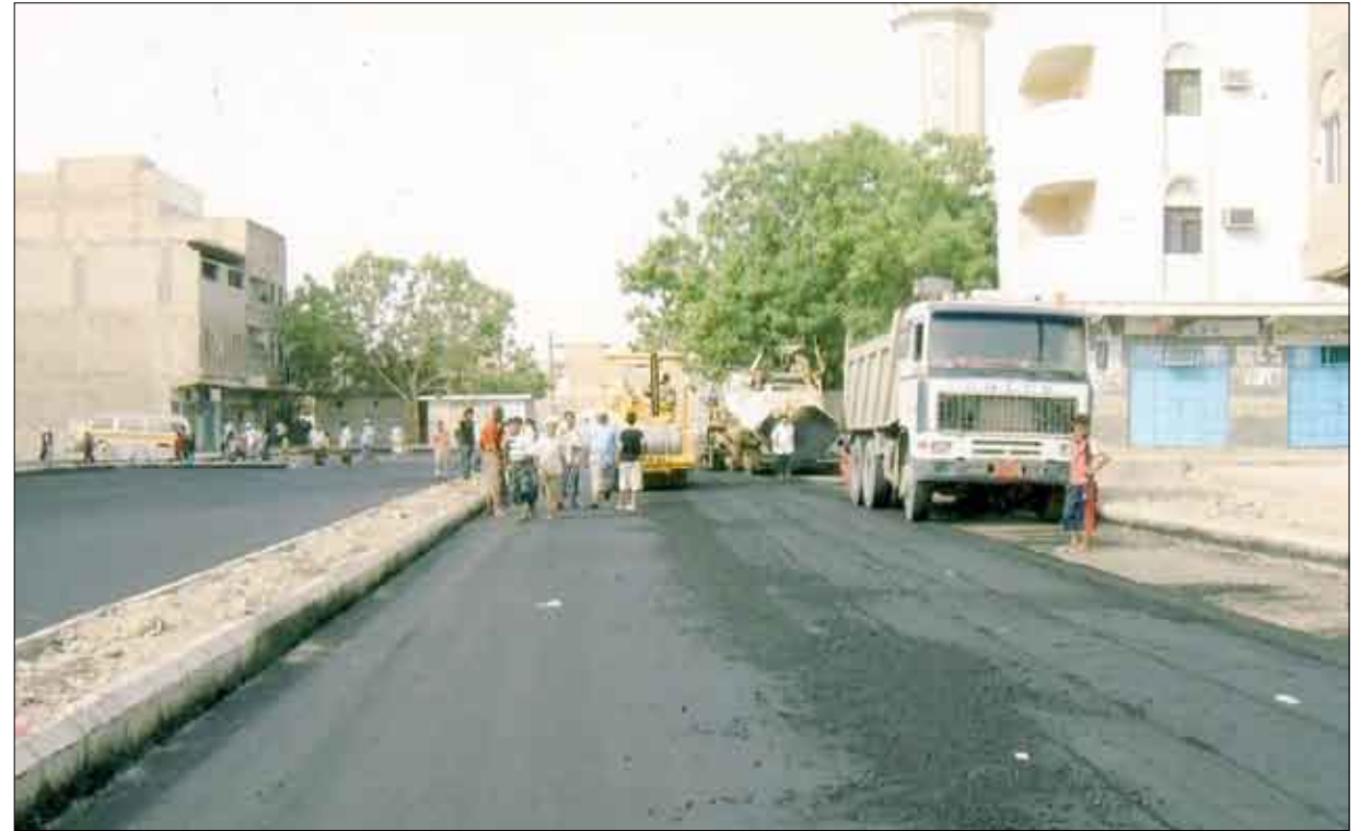
من أعمال صيانة ورصف الطرق
