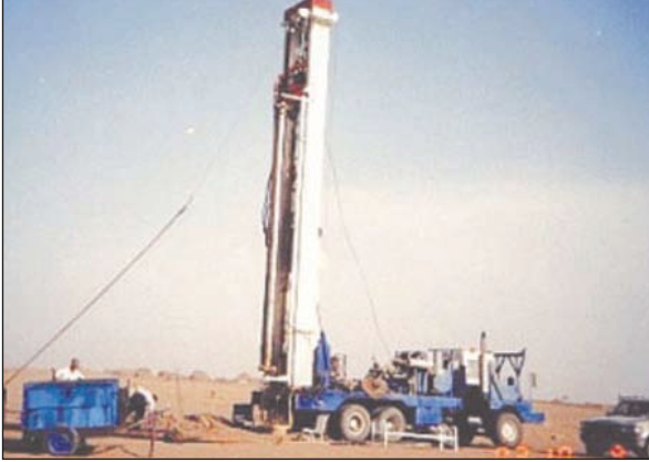
أحد مشاريع حفر واستخراج المياه في الريف
