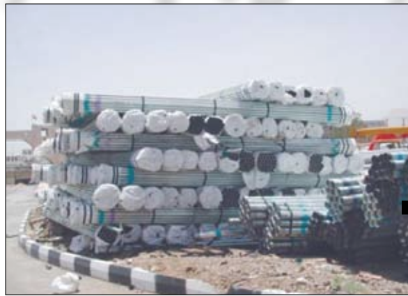
أنابيب مياه لمشاريع المياه في الريف
