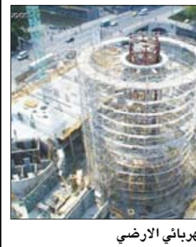
الارث الكهربائي الارضي
