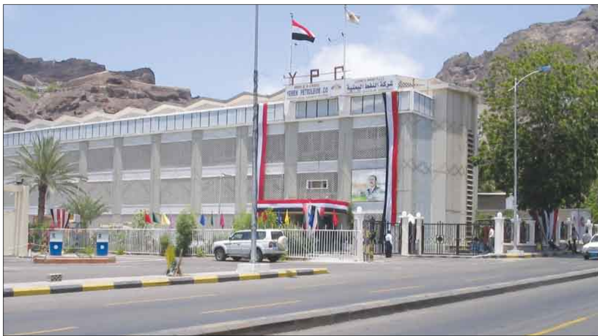
مبنى شركة النفط
