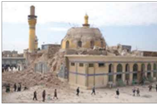
■ المرقد قبل الهدم
