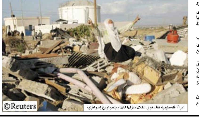
أمرأة فلسطينية تقف فوق أنقاض منزل المهدم بصواريخ إسرائيلية
