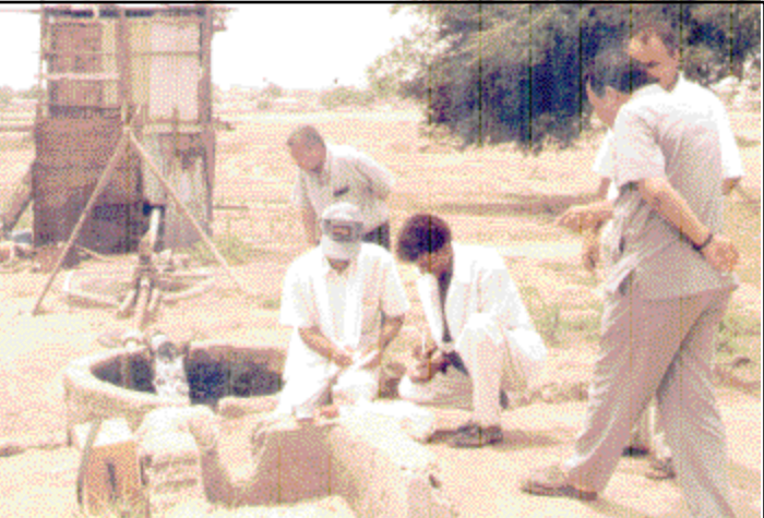
تصوير لقطاع المياه والصرف الصحي في مدينة تعز
